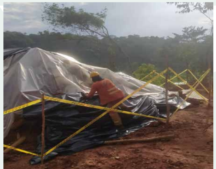
Foto : Almacenamiento de Materiales
