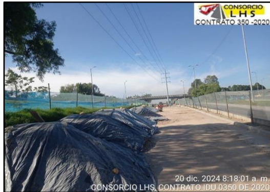
Foto : Almacenamiento de materias pétreos
